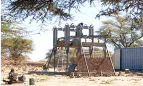
12 Meroe Royal Baths, Testbau im Rahmen der Schutzbau-Planung: Montage der Träger für die Dachabdeckung, darunter die Tonnengewölbe, das vordere noch über Lehrgerüst. Ausführung einer Musterfassade in zwei unterschiedlichen Brandziegelverbänden. (Foto: J. Herraiz Martinez/Kéré Architecture, 20200222_DG-2908_JH)
