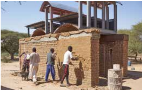
13 Meroe Royal Baths, Testbau im Rahmen der Schutzbau-Planung: Fertig gestellte zweischalige Dachabdeckung auf dem gegossenen Ringbalken. Ausführung einer weiteren Musterfassade mit gelblichem Kalkverputz auf dem Lehmziegelmauerwerk. (Foto: H.-U. Onasch/DAI, D-DAI-Z-MRB_20200304_DG-8903_HU)
