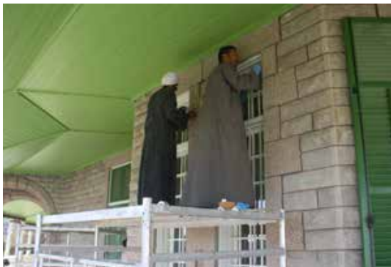
6b Reinigungsarbeiten am Natursteinmauerwerk des historischen Museums auf Elephantine. (Foto: M. Sählfhof/DAI)
